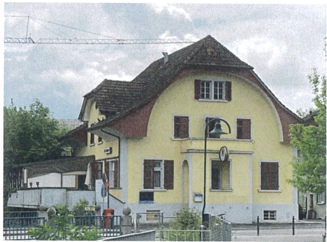
Abbildung 1: Das Wohn- und Gasthofgebäude heute
