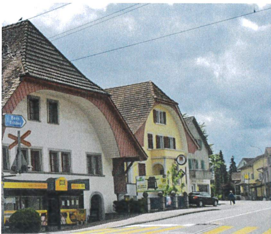
Abbildung 2: Die Lage am Dorfkern, links der "Alte Engel", mittig das Bauvorhaben
