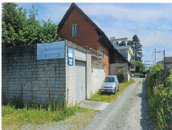
Blick über das Baugrundstück von Südwesten nach Nordosten
