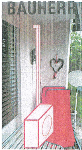
Fotos Position Aussengerät auf Boden gestellt
