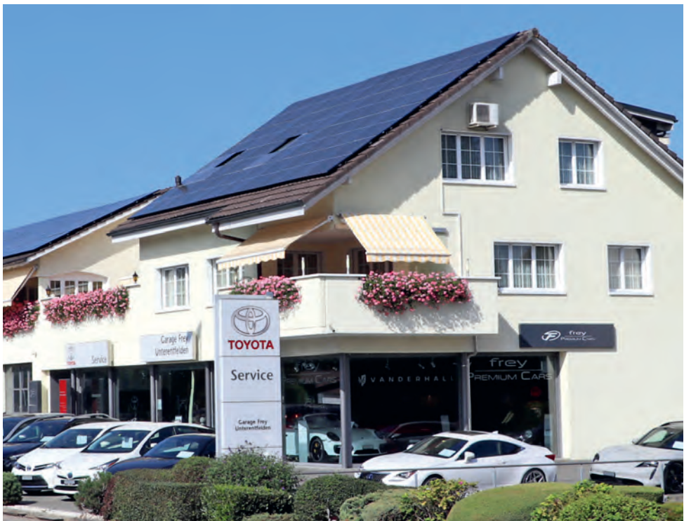
Die Photovoltaikanlage beeinträchtigt die Aussenansicht der Garage Frey nicht. Sie zeugt von einem neuzeitlichen Denken eines modernen Betriebes Bilder: Garage Frey
